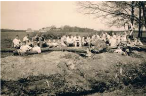
Frühstückspause am Aldorfer Graben während der Rodungsarbeiten 1939
