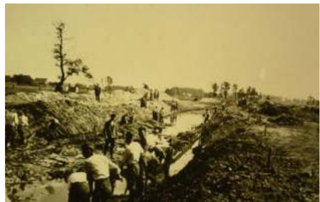
Arbeitsmänner beim Ausbau des Moorkanals an der Dadau in der Gemeinde Drebbler
