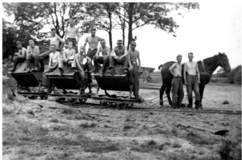
Arbeitsmänner haben in Holzort (Gemeinde Eydelstedt) Sand abgetragen den sie mit Loren, die das Pferd von Thesing zieht, in die Huntewiesen zur Befüllung transportieren
