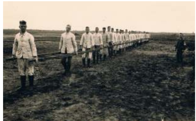
Verlegen von Schienen im Dreeker Moor
