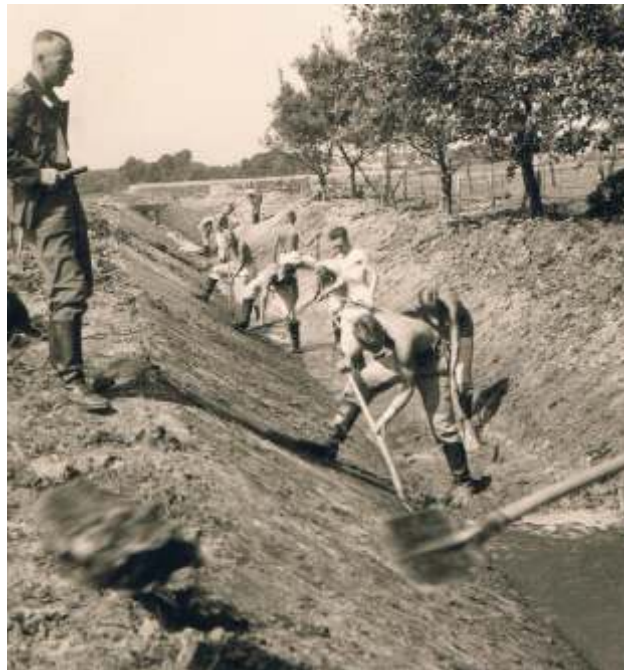
Bau des Aldorfer Grabens im Jahr 1939
