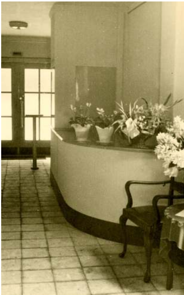
Vorraum mit Blick zur Eingangstür
