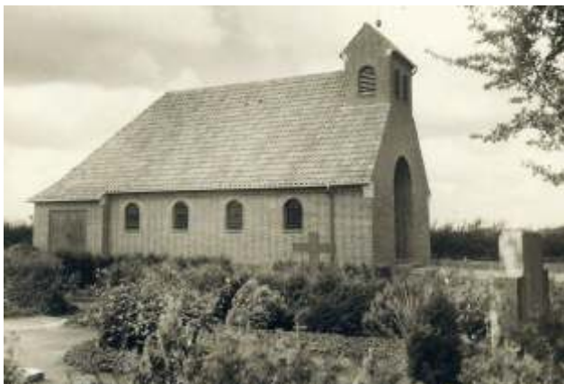
Friedhofskapelle Barnstorf Südseite
