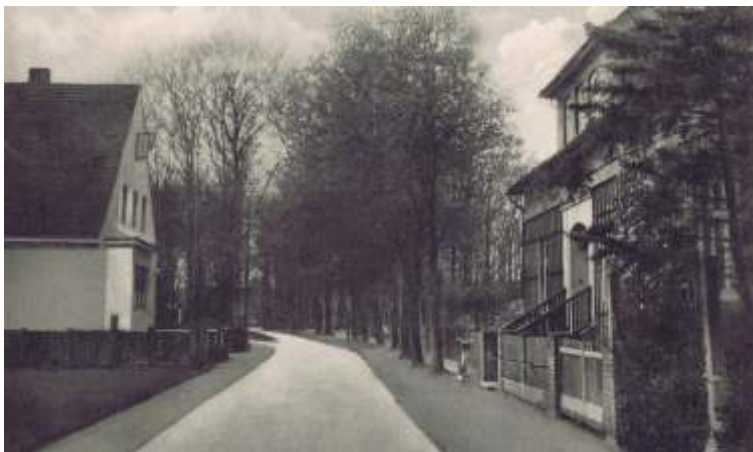
Alte Ansicht der Friedrich-Plate-Straße
