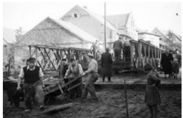
Fußgänger passieren die Brücke bei laufenden Arbeiten
