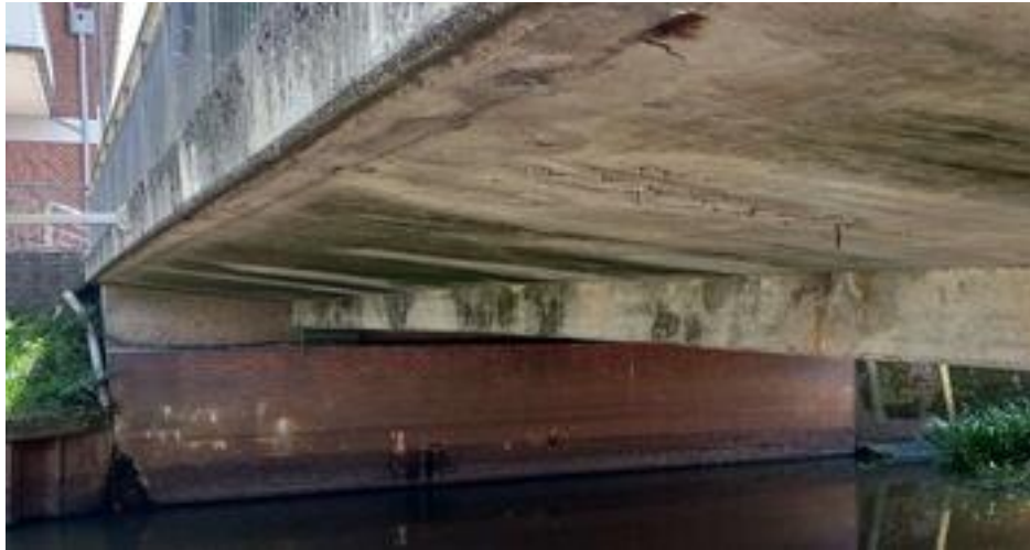
Blick unter die Brücke mit Fahrbahntafel und Fundament
