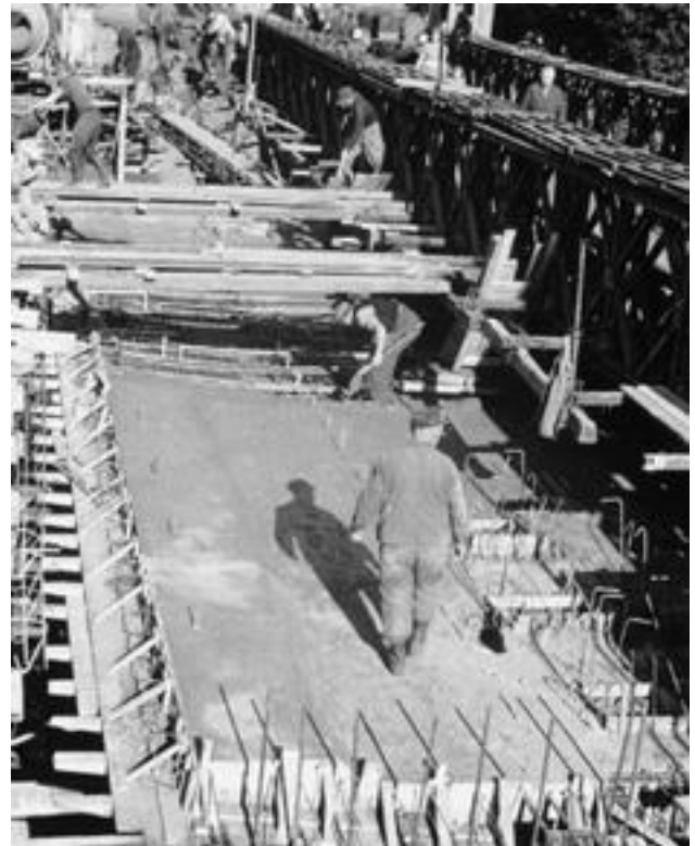
Herstellung der Fahrbahntafel
