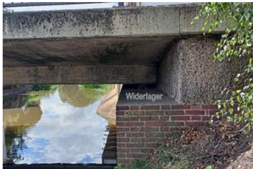
Fundament und Widerlager
