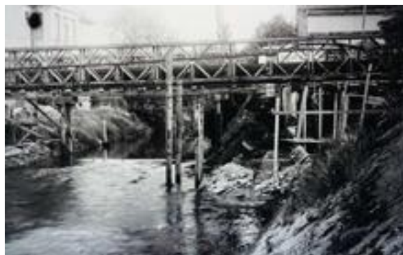
Erste Arbeiten unter der Behelfsbrücke
