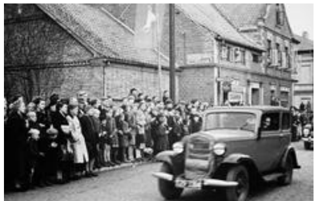
Das erst Auto passiert die neue Brücke
