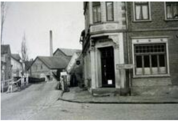
Die Rampe für die angehobene Brücke
