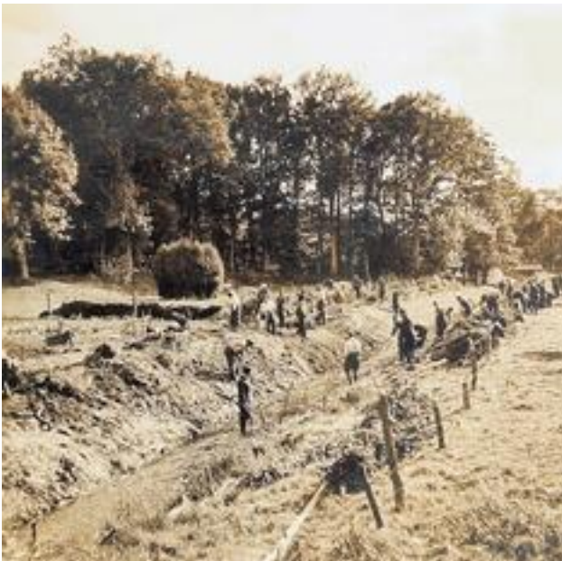
Ausbau des Aldorfer Bach
